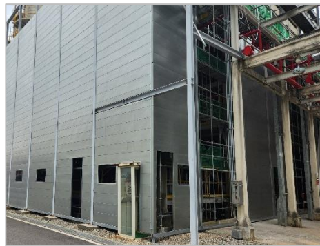
소음 저감 목적 방음벽 설치
